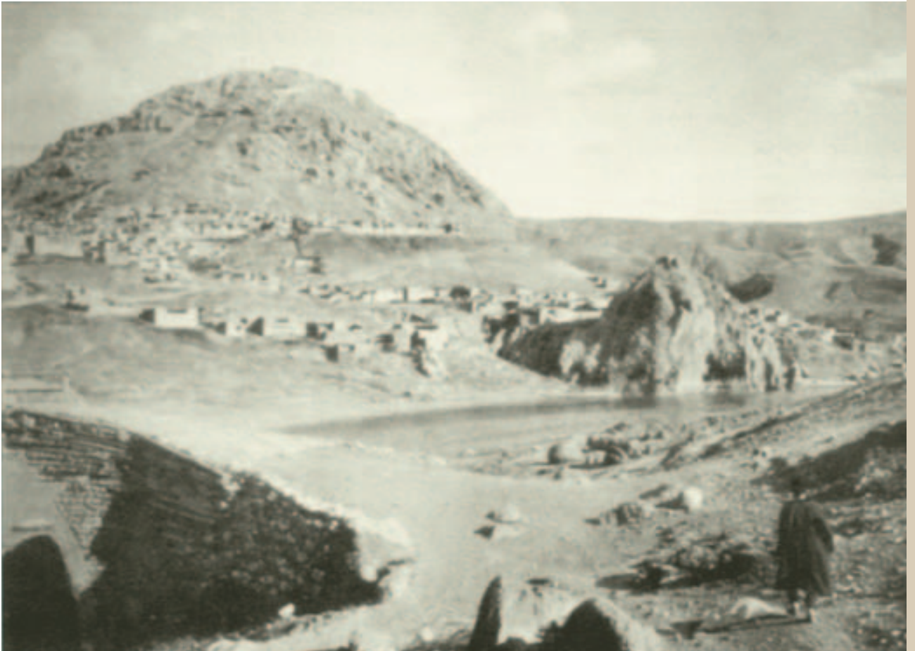
1901 Palu Aşağı Mahalle / Foto: S. Yapıcı Arşivi
