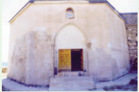
Cemşid Bey Türbesi / Foto S. Yapıcı Arşivi
